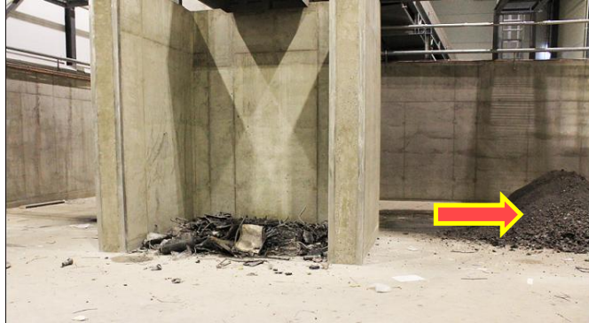
Kuva 2. Kuonabunkkeri, jossa magneettisten metallien erottelu
